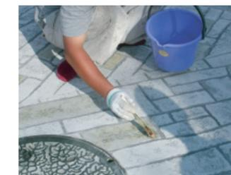
この作業を隣へと隣へと続けていきますが先に塗ったステインクリートXが乾いたところに新しいステインクリートXを塗布するとはっきりと継ぎ目が出てしまいますので、継ぎ目が出ないように素早く連続的に行ってください。基本的には2回塗りです。
