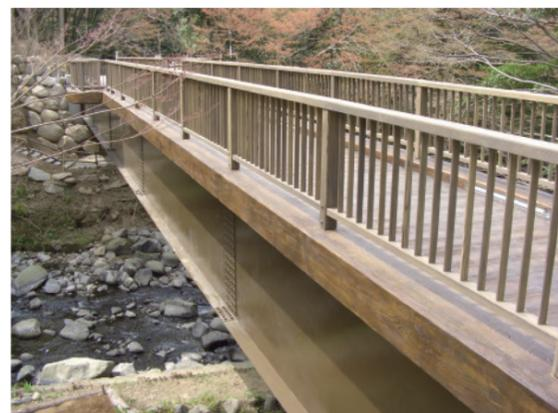
鋼製の橋の欄干をモルタル造形で化粧しステインクリートで着色しました。
