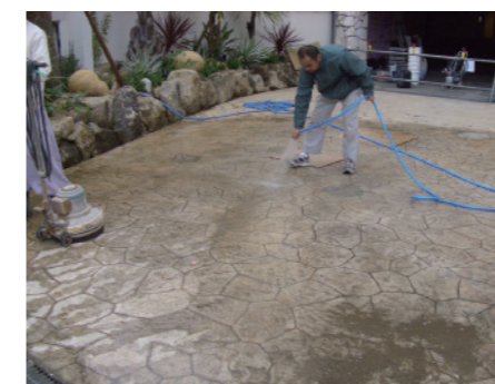
汚れて劣化した表面を洗浄
